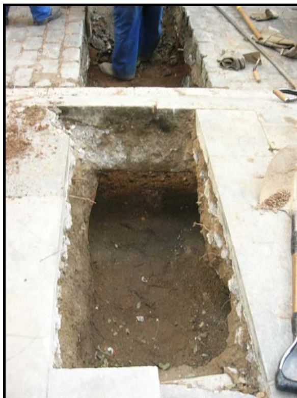
Foto 3. Primer tram travesser buidat.
