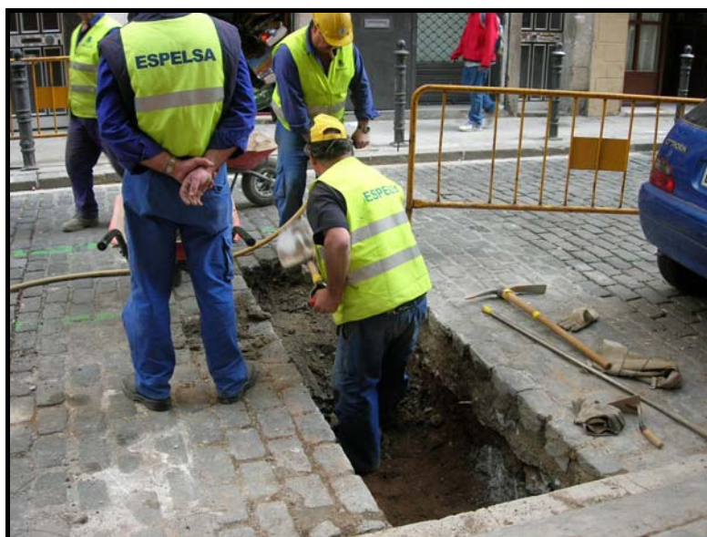
Foto 4. Personal de l'obra efectuant el buidat manualment.
